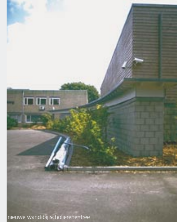
aansluiting wintertuin aan bestaande school met zicht op de lage dakkdelen
