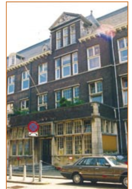
Voorzijde pand gerenoveerd
