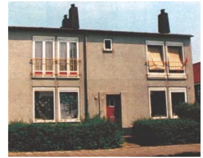
De opknopbeurt uit de 80er jaren haalde de karakteristiek uit het complex
